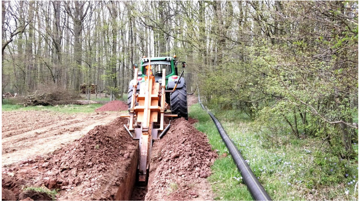
Offenes Bauverfahren mit der Grabenfräse
