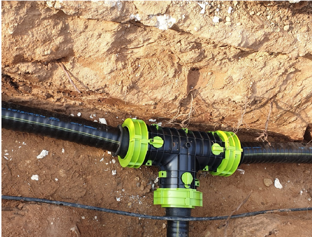
T-Stück im offenen Graben
